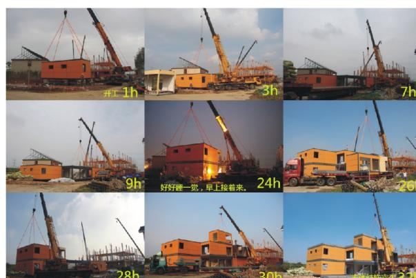
该示范楼通过集成建筑模块化设计、模块单元连接及建造、适用绿色建材研发应用三大关键技术，实现从组件到成品房屋全方位个性化定制。示范楼建筑面积为460平方米，由15个模块单元组成，拥有办公、住宿、会议、展览、餐饮等功能，集绿色建材、节能设备、智能系统、新能源和现代制造为一体，是我国首座绿色建筑二星级全模块化建筑。示范楼主体结构采用预制模块单元积木式吊装构建，建造时间仅32小时，工厂预制化率达到90%以上，相比传统现浇建筑体系可节地20%、节能70%、节水80%、节材20%，全面展示了快捷、智能、低碳、健康等特色。
